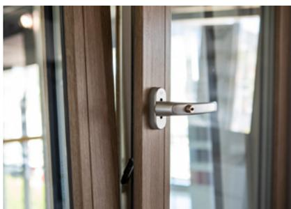
Diese Lösung zielt darauf ab, den Flügel in der gekippten Position zu blockieren, nachdem der Griff um 90 Grad horizontal gedreht wurde, was eine Bewegung des Flügels von der gekippten in die offene Position des Fensters nicht zulässt. Erst nachdem der Griff mit dem Schlüssel entriegelt wird, kann das Fenster geöffnet werden. Diese Lösung garantiert die Sicherheit der Kinder und ermöglicht gleichzeitig die Belüftung des Raumes bei angekipptem Fenster.
